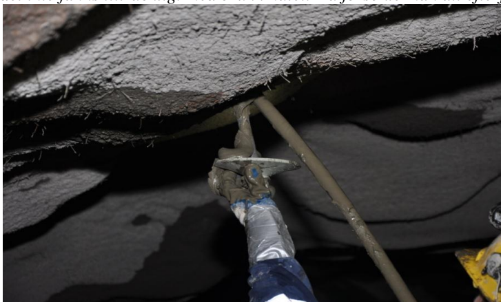
Bild 15. Citybanan. När man satte in bulten i hålet som skulle ha varit fyllt av cementpasta upptäckte man att det inte fanns tillräckligt med bruk i hålet. Då försökte man att efterfylla vilket betyder en misslyckad bult.
