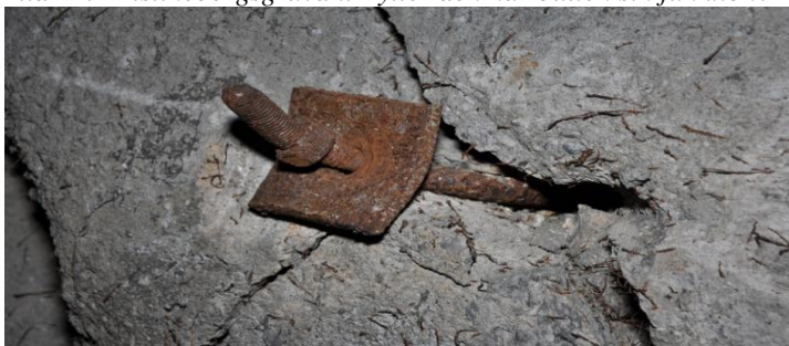
Bild 12. Kristinebergsgruvan. Fyller den här bulten sin funktion?
