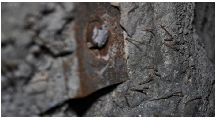
Bild 12. Kristinebergsgruvan. Fyller den här bulten sin funktion?
