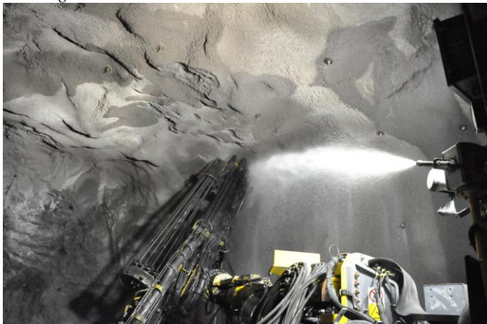
Bild 18. Kirunagruvan. Bultsättning med automatiserad rigg. Det finns frågetecken runt brickas anläggning mot berget samt den visuella känslan av resultatet.
