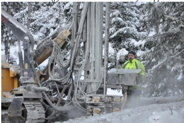
Bild 23. Borrning för testbultar Lövsta utanför Uppsala.
