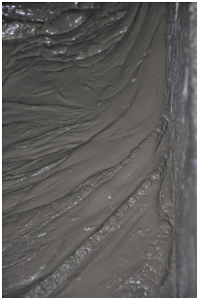
Bild 9. Bultsättning i Kristinebergsgruvan. Notera cementpastan som kommer ut ur hålet, är det korrekt vct?
