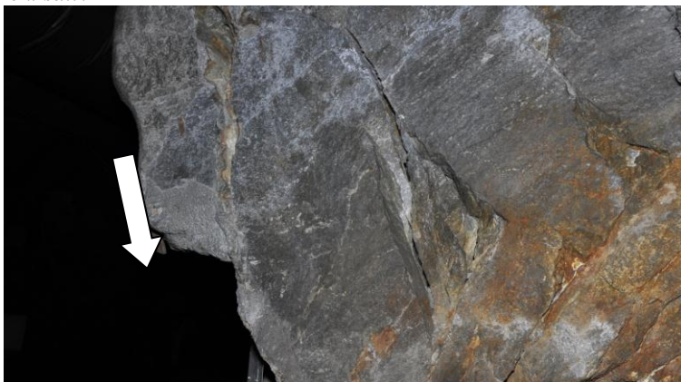
Bild 7. Dåligt bergparti i Kristinebergsgruvan. Notera den enda bulten som håller ihop partiet, är den korrekt satt?
