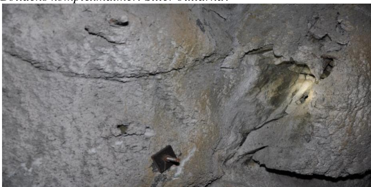
Bild 10. Ytterligare ett dåligt bergparti i Kristinebergsgruvan. Dåligt berg är det naturliga tillståndet för Bolidens komplexmalmer. Sitter bultarna?
