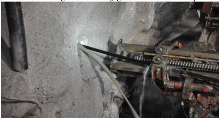
Bild 9. Bultsättning i Kristinebergsgruvan. Notera cementpastan som kommer ut ur hålet, är det korrekt vct?
