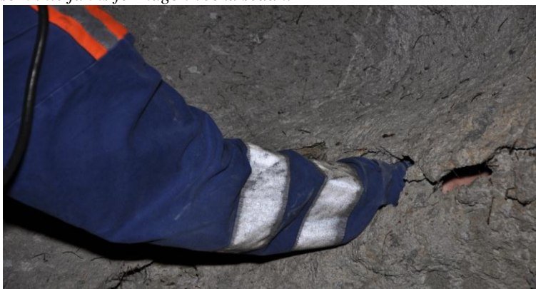
Bild 13. Kristinebergsgruvan. Bolidens Bergmekaniker Daniel Sandström stoppar in handen i en bergspricka som inte fanns för någon vecka sedan.
